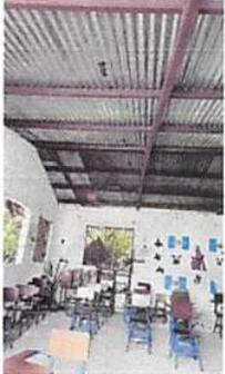
Foto1: fabricacion de ventanas, reparacion y resanado de estructura portante, e instalacion de lamina troquelada calibre 26
