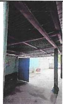
Foto 5: fabricacion e instalacion de estructura portante y sustitucion de lamaina por lamina troquelada calibre 26
